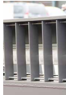
Noordbrug Kortrijk Bridge
